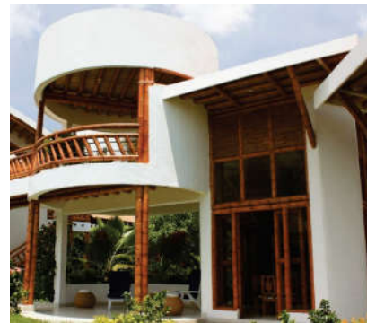
(c) Residência finalizada.
