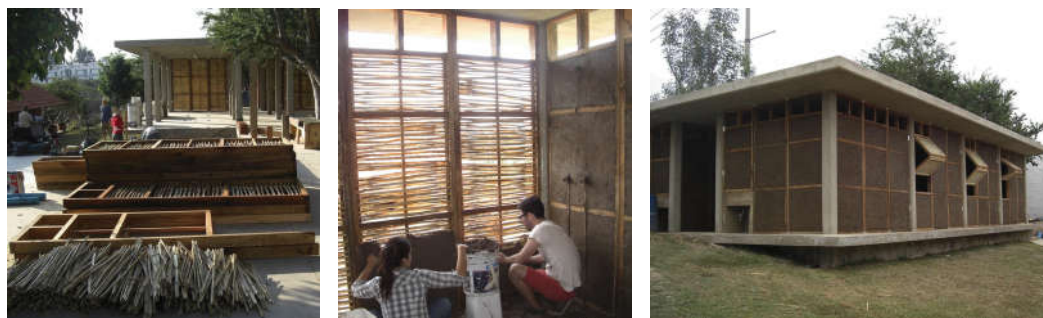
(a) Madeira e bambu. (b) Aplicação da argamassa. (c) Edifício finalizado.
