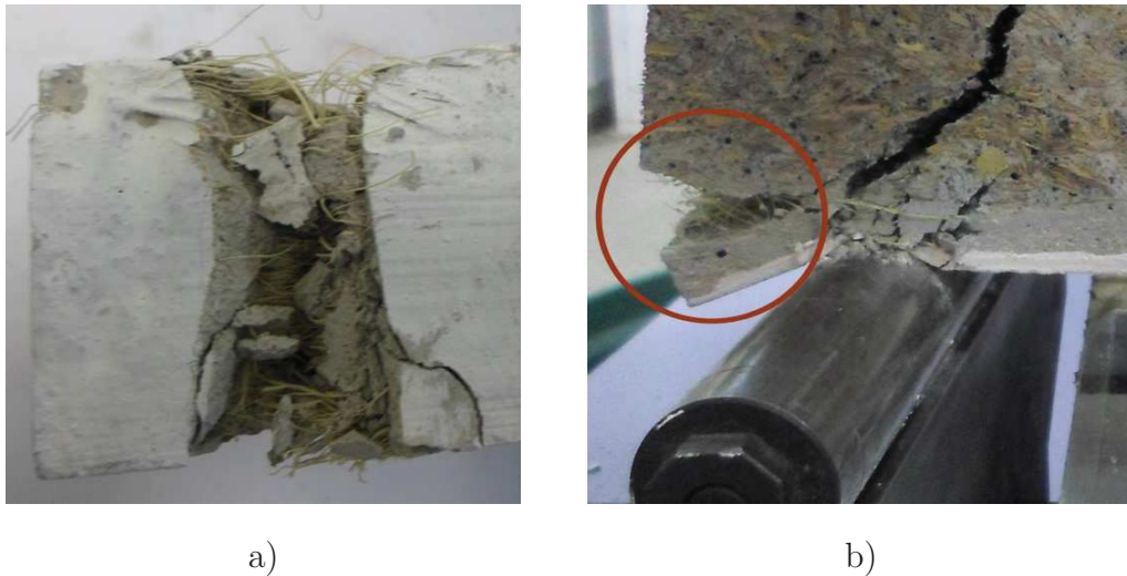
Figura 4.45: Localizações de fissuras na face inferior do PS 2,5
