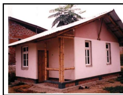
Figura 2.17- Edificações construídas com painéis de bambu revestidos com argamassa. Fonte: ACFA (2005); Teixeira (2006)
