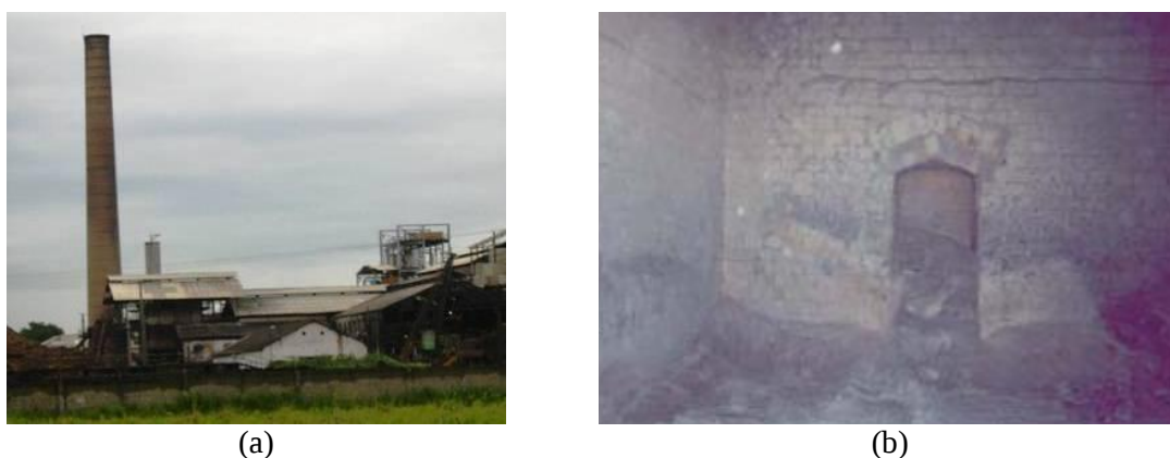
Figura 3.1 – Vista externa da caldeira da Usina Barcelos (a) e vista interna do salão da caldeira após a limpeza (b) (CORDEIRO, 2006). Fonte da imagem “a”:
