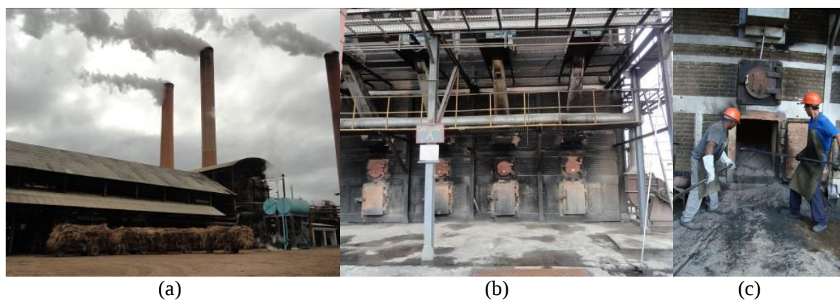
(a) (b) (c) Figura 3.3 – Vista externa das chaminés das caldeiras da Usina AGROVALE (a), depósito de bagaço de cana-de-açúcar no pátio da usina (b) e vista frontal da fornalha durante a queima do bagaço (c).
